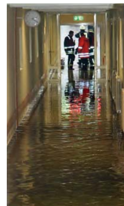
Trotz aller Bemühungen von Feuerwehr und technischem Dienst lief das Wasser in das Kellergeschoss.
